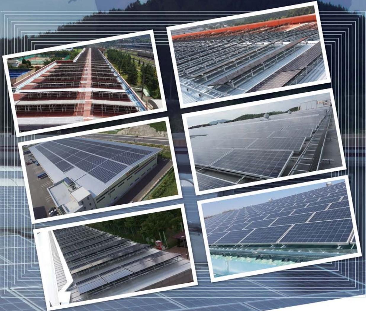
대부분의 건축물 지붕은 태양광 발전 설비를 설치하도록 설계되어 지어지지 않았기에, 태양광 설치에 있어서 많은 난제들이 발생합니다. 북반구 기준으로 태양광 모듈을 정남으로 설치하여 야하나 원하는 각도로 설치 하기 위해 지붕을 정남으로 다시 지을 수는 없기에, 지붕위에 설치될 태양광 구조물을 정남에 원하는 각도로 설치를 하는 것이 가장 효율 적인 방법 입니다. 이를 위해 먼저 바닥에 레일 앵글 또는 레일 채널을 설치 하고 이 위에 삼각 프레임 사용하여 시공하는 방법이 가장 최적의 시공법입니다.
